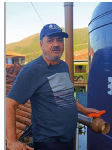
A água está sendo captada do Poço Artesiano e bombeada diretamente para a estação de tratamento de água em Santa Rita de Cássia.
