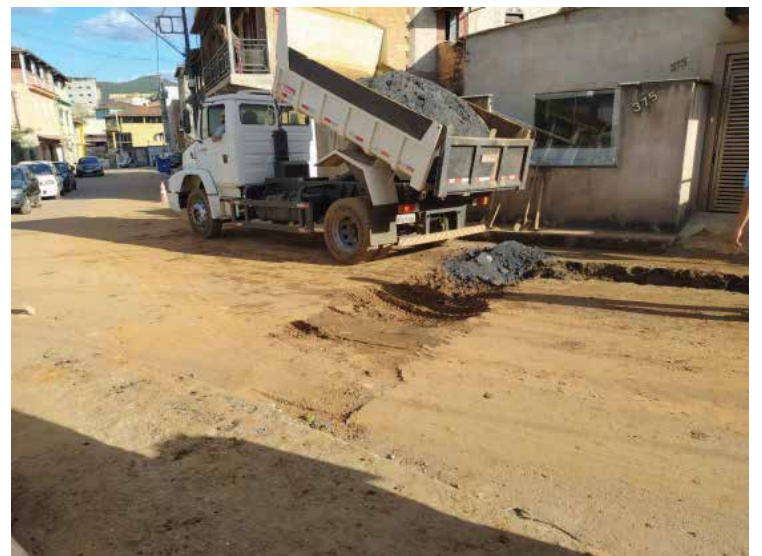
Foto durante as obras.
