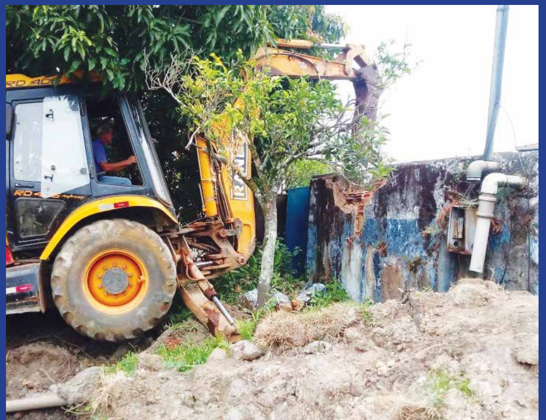
Reservatório do bairro Rosário começa a ser demolido.
